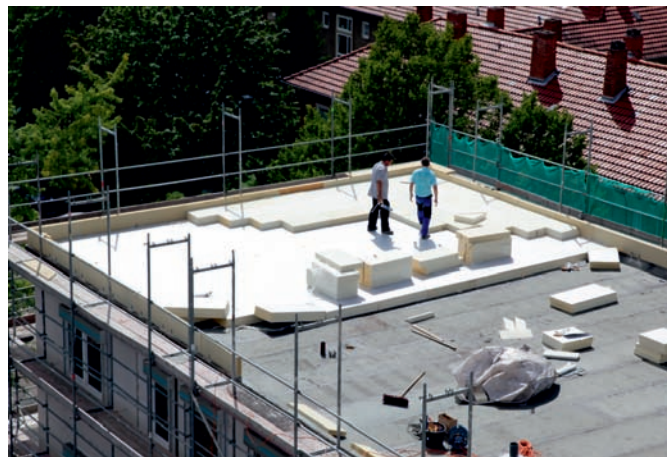
Verlegezustand: Dachrand und Dämmarbeiten sind parallel möglich.
