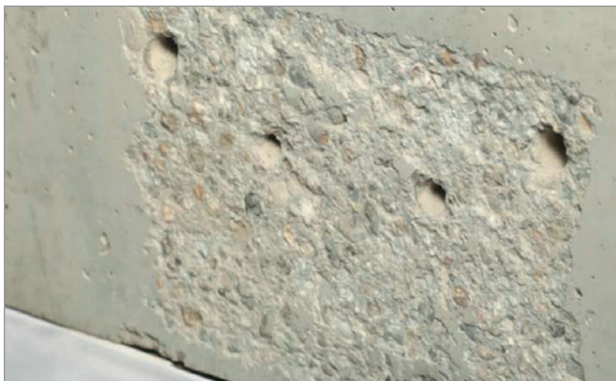
Abb. 3: Die Stirnfläche der Bestandsdecke wird komplett aufgeraut um den Verbund zu gewährleisten. © Schöck
