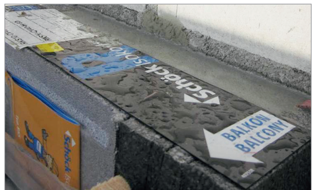
Abb. 8: Im letzten Schritt wird die Vergusstasche mit speziellem Mörtel verfüllt. Damit wird die Druckzone des Anschlusses kraftschlüssig mit der Decke verbunden. © Schöck
