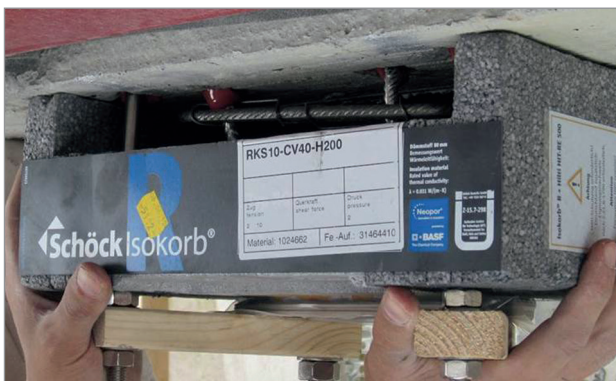
Abb. 7: Das Injektionsmaterial muss nun aushärten. In diesem Bild ist die Vergusstasche zu sehen, die im nächsten Schritt verfüllt wird. © Schöck
