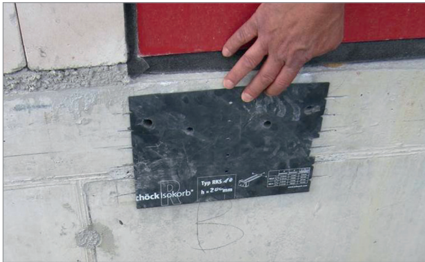
Abb. 1: Nachdem die richtige Position für den Anschluss ermittelt wurde, werden die Bohrlöcher mit Hilfe einer Schablone angezeichnet. © Schöck
