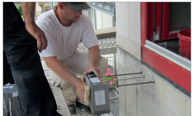
Abb. 6: Der Isokorb® R wird von außen in die Bestandsdecke eingeschoben. © Schöck
