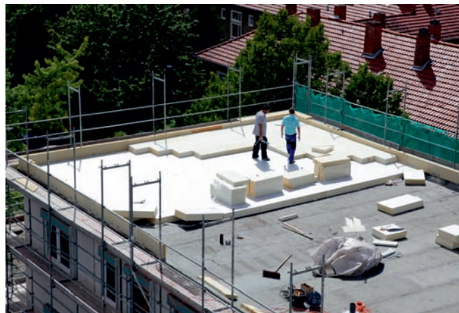
Verlegezustand: Dachrand und Dämmarbeiten sind parallel möglich.
